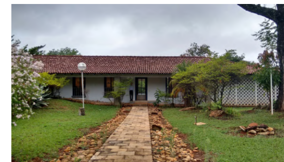
FIGURA 6.29. Casa de Oscar Niemeyer em Brasília. Fonte: Archdaily
